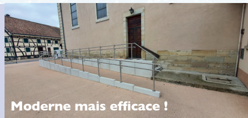
La rampe de l'église
