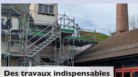
Désamiantage de la toiture de la salle des fêtes
