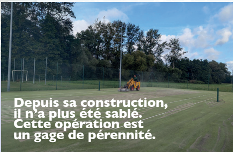
Réfection du cours de tennis
