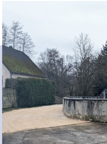
Empierrement de la rue Saint Martin
