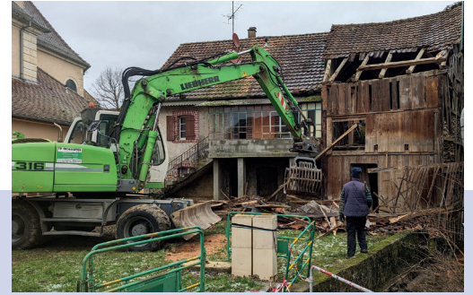
Démolition de la maison 2 rue de Willer, pour faire place à un espace vert et des places de stationnements.
